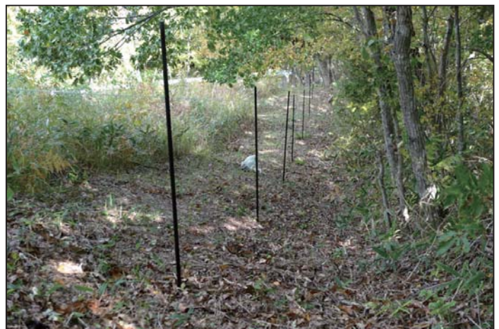
電気柵の杭を設置する (10/17)
