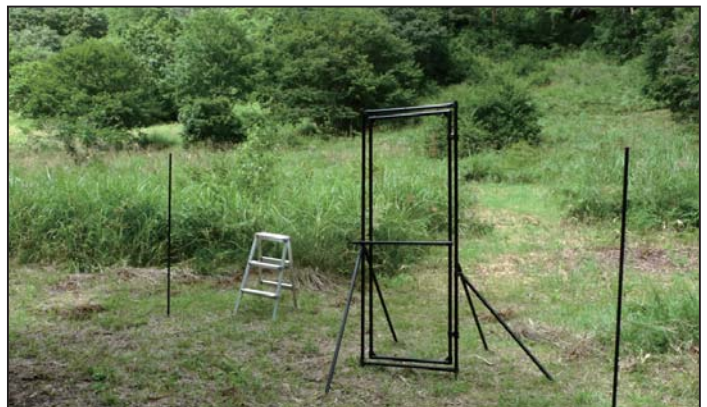
電気柵の出入口ドアの設置 (8/30)
